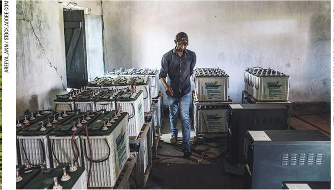
**Lokale Netze – so genannte Microgrids – können Regionen mit Strom versorgen, die Überlandleitungen nicht erreichen. Solarmodule (links) liefern per Microgrid Strom für ein Dorf. In einem anderen lokalen Netz speichern Batterien die Solarenergie für trübe Tage (rechts).**
