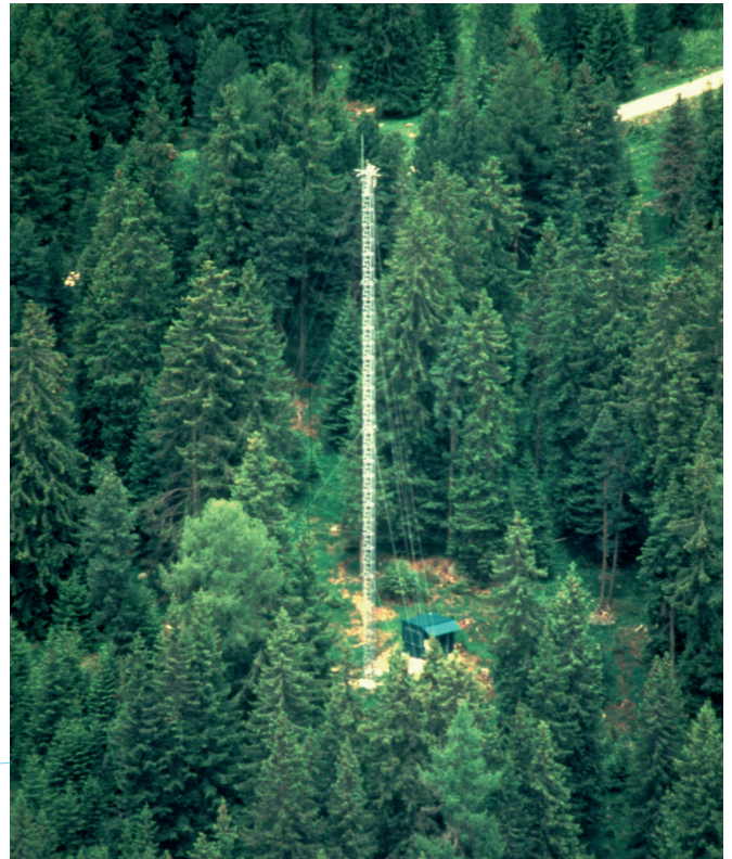
Ein mikrometeorologischer Messturm von oben betrachtet, Renon/Ritten, Italien
