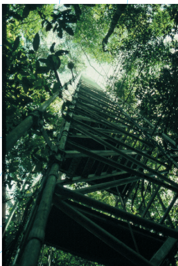
Das Projekt LBA Carbonsink: Ein mikrometeorologischer Mess- turm mitten im dichten Regen- wald im Amazonasbecken in Brasilien
